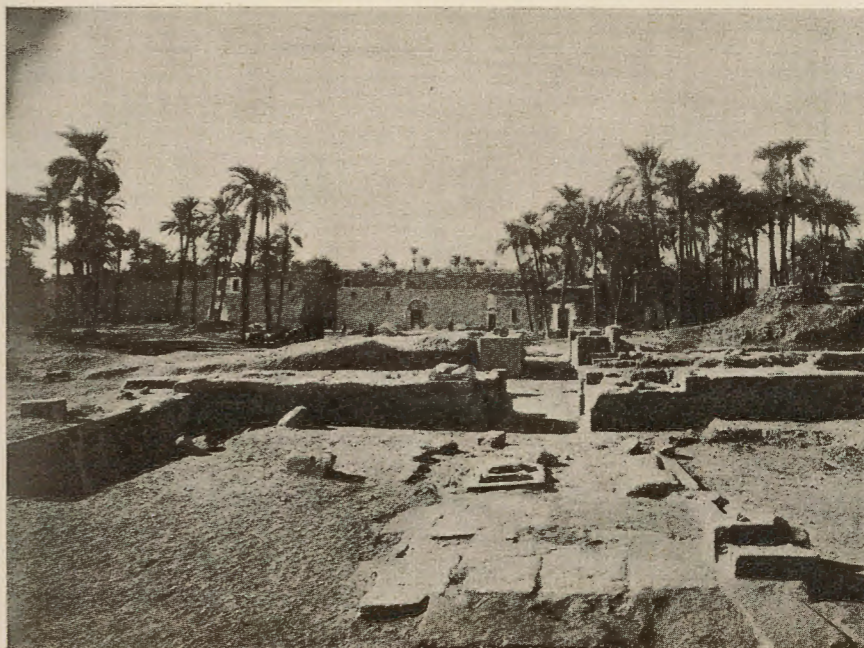
La cour et l'avant-cour d'Opet vues de l'est.
